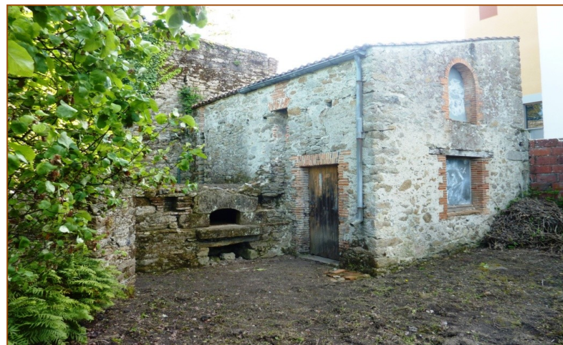
Four central accolé à la médiathèque
